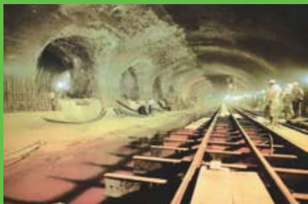
Foto 3 - Vista do interior da Estação Consolacão durante a escavação, Metrô de São Paulo (CBT – 2006)
