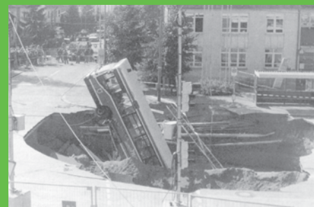
Foto 11 - Colapso de túnel em Munique, Alemanha (Ribeiro, 1999; Ribeiro & Kochen, 2000)
